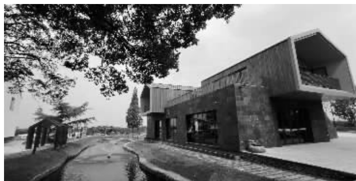
污水处理设施建设,有效提升水环境 惠山城管供图
