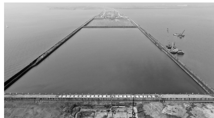
施工现场 无锡市建管中心供图
