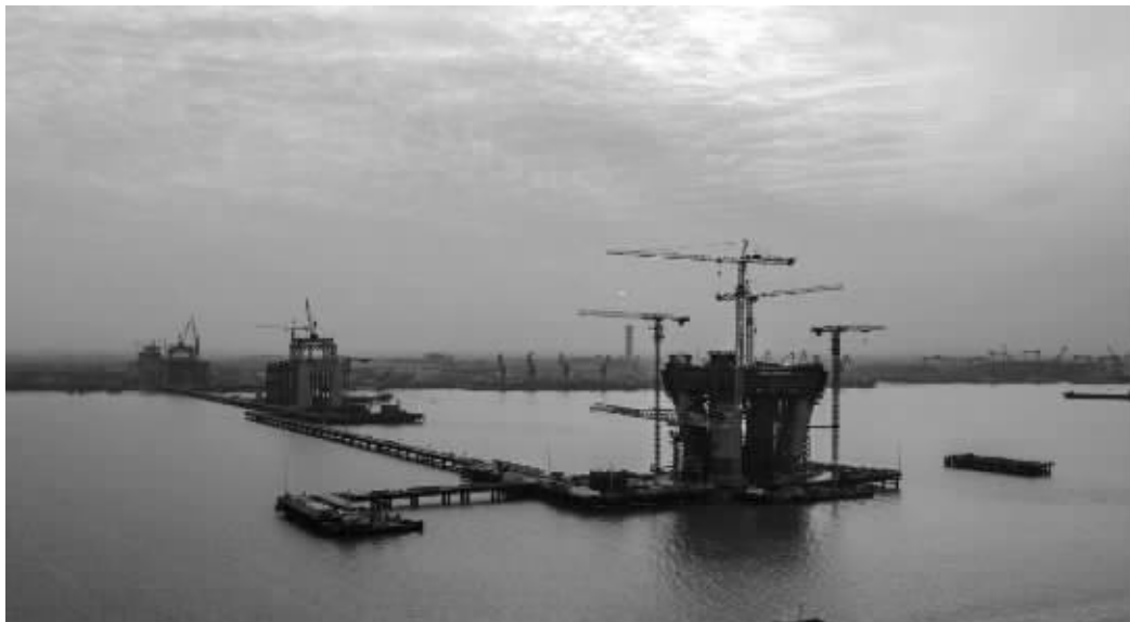
4月16日,经过300多名建设者14天的日夜奋战,常泰长江大桥北主塔顺利完成横梁混凝土浇筑。至此,这座世界在建最大跨度公铁两用斜拉桥大桥的南北主塔横梁浇筑施工全部完成。图为常泰长江大桥5号墩主塔施工现场,承建单位中交二航局的工人对主塔横梁进行浇筑作业。 汤德宏 赵振宇 毛晓华 摄影报道
