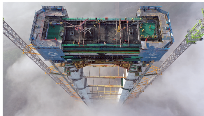
龙潭长江大桥施工现场 江苏省交建局供图
