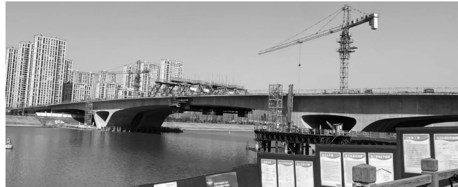
施工现场 通讯员供图
