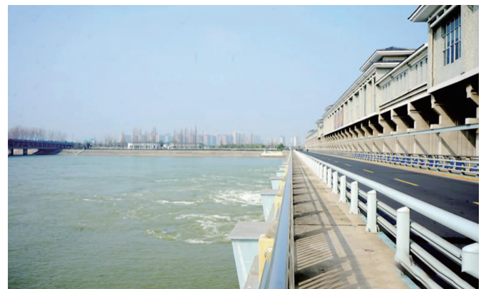
万福闸开闸行洪,积极“迎战”淮河春汛 通讯员供图
