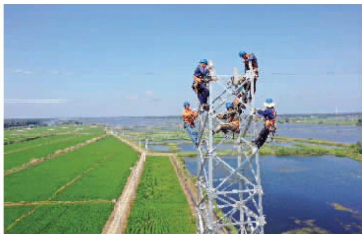
2021年8月3日，金湖县宝应湖农场九大队，国网淮安供电公司工作者在高空中立110千伏红前线10号铁塔 梁德斌 摄
