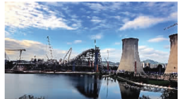
施工中的滑雪大跳台 2022北京新闻中心供图
