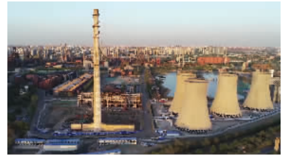
首钢园区旧貌
