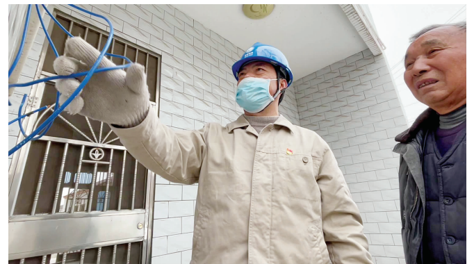
周维忠在帮助村民检查电路
