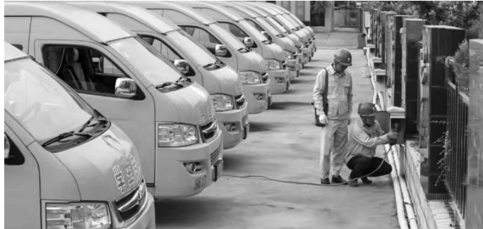
供电部门工作人员正在作业 通讯员供图
