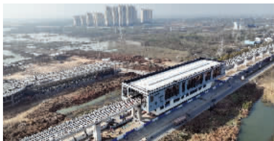
上图:南京紫峰大厦 下图:宁滁城际铁路首座车站(相官站)竣工
