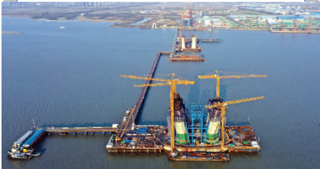
常泰长江大桥主塔下塔柱全部施工完成 通讯员供图
