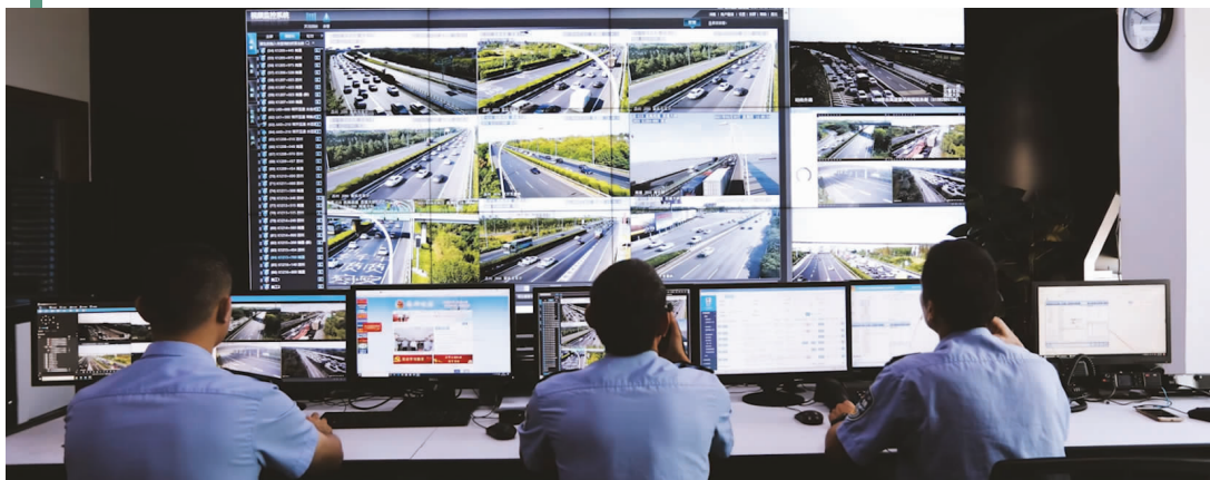
通过科技手段实时监管高速公路通行情况
