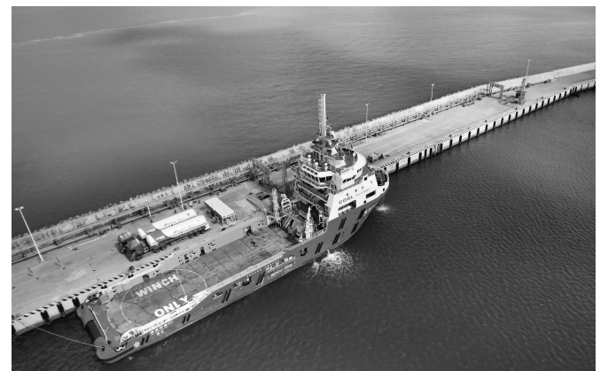
11月20日,在海南马村港LNG船舶加注站,船舶在加注燃料(无人机照片) 新华社记者 杨冠宇 摄
