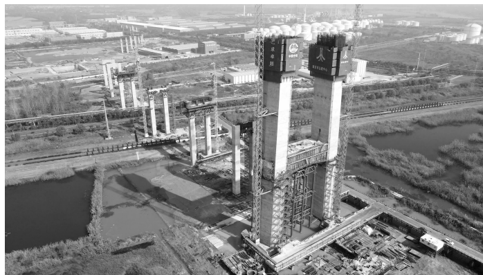
建设中的仙新路过江通道北主塔 赵懿供图
