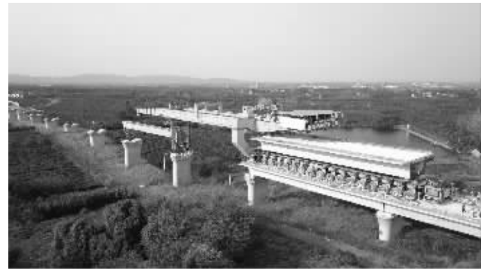
南沿江城际铁路金坛段茅麓茶场大桥正在架梁施工 中铁十六局供图
