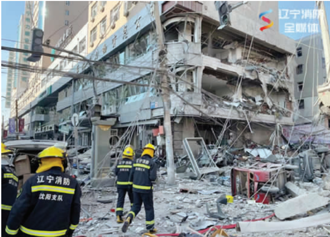
爆炸现场 据辽宁消防官方微博
