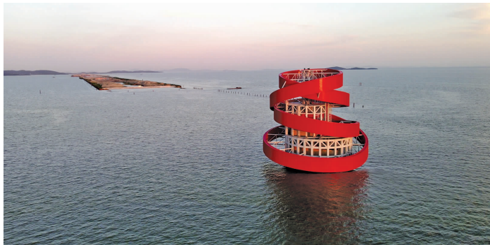
太湖隧道“碧玉螺”风塔 江苏省交建局供图
