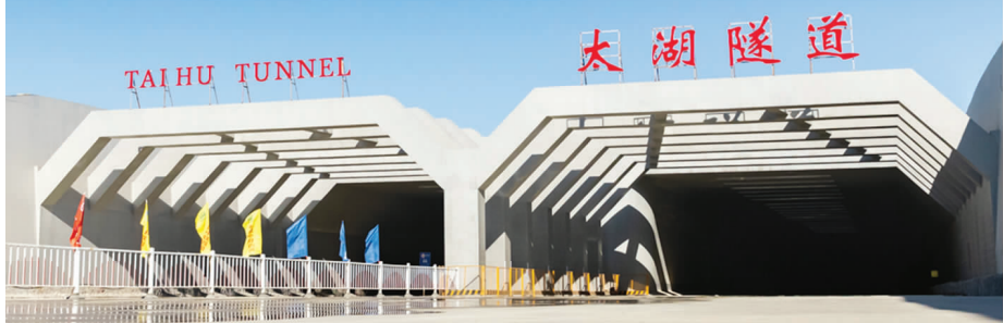
太湖隧道入口处 江苏省交建局供图
