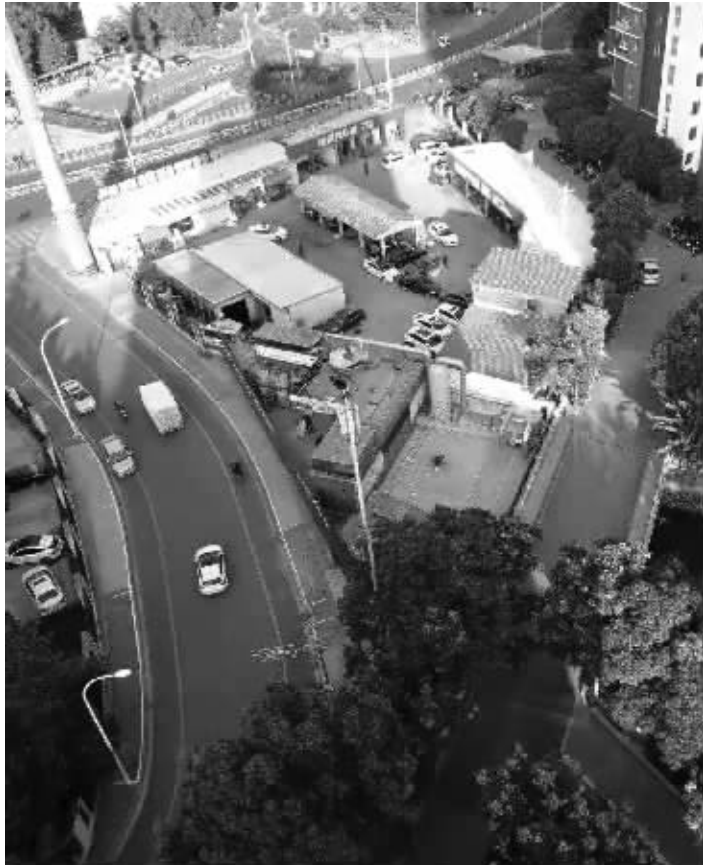
►设置在塔影河李巷浜交界处的临时MBR装置
