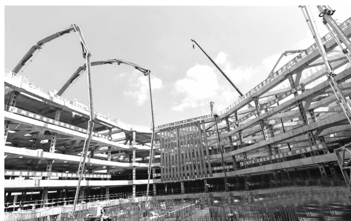
江北新区500米超高层大底板混凝土浇筑现场 建设单位供图
