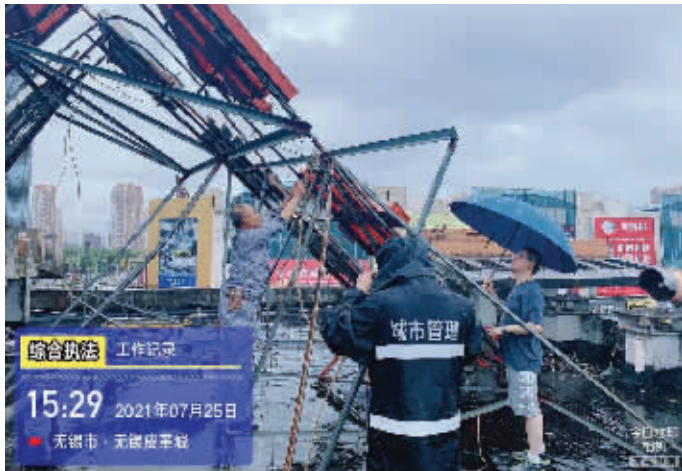
锡山城管拆除有安全隐患的楼顶广告 锡山城管供图
