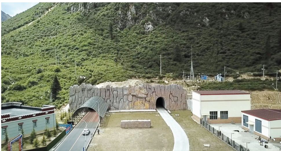
过去,翻越雀儿山海拔5000多米的垭口,车程大约两小时。如今,人们穿越雀儿山隧道,只要10分钟车程
