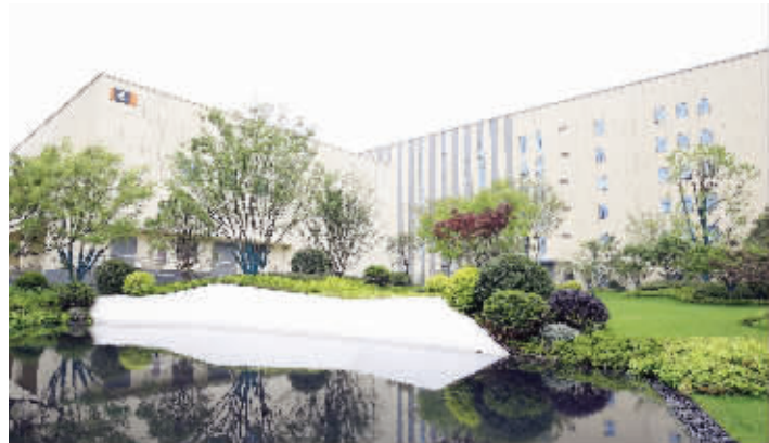
中国移动长三角(南京)数据中心外景
