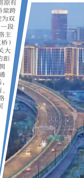
312国道龙华立交至张店枢纽段改扩建工程 通讯员供图
