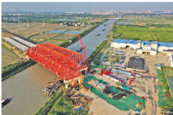
溧宁高速芜太运河特大桥主桥贯通 通讯员供图
