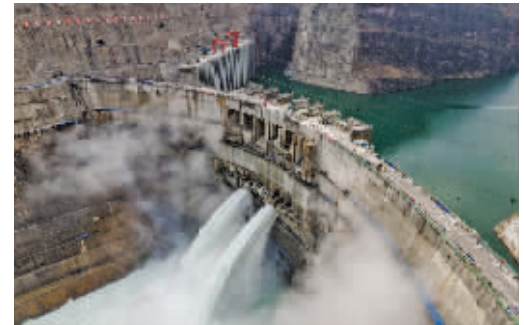
5月31日,白鹤滩水电站大坝实现全线浇筑到顶。白鹤滩水电站,是开发和治理长江上游的重要水电工程,是国家能源战略布局“西电东送”的骨干电源点。 新华社发
