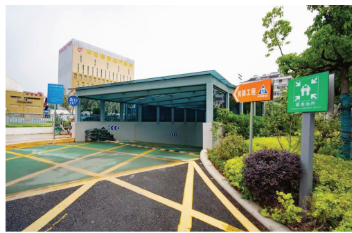
避难场所 省住建厅供图
