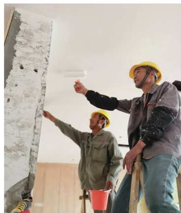
5月3日,建筑工人曹均、曹明泉放弃假期休息,与工友们奋战在工地上
