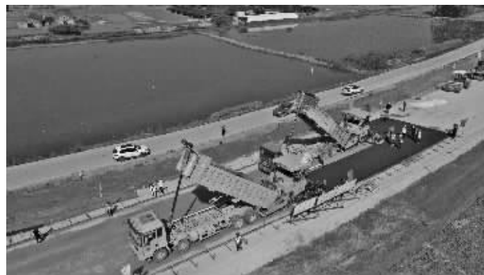
溧宁高速进入路面施工阶段 通讯员供图
