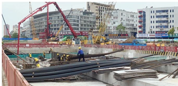
施工现场 通讯员供图
