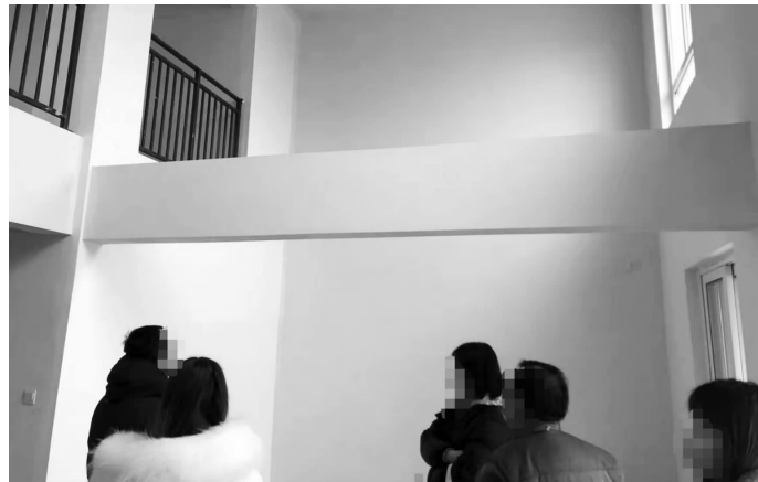
客厅上方有承重横梁 业主供图
