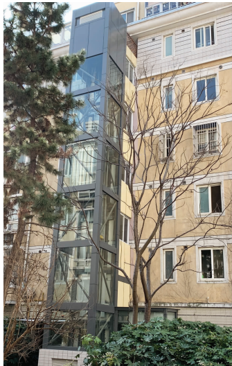
8幢乙单元房屋北侧加装的电梯
