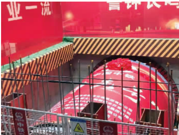
西安地铁八号线进入盾构施工阶段,发现大批古墓 图片来源:西安市文物局
