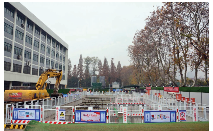
地铁6号线明故宫站施工现场 图片来源:南京地铁
