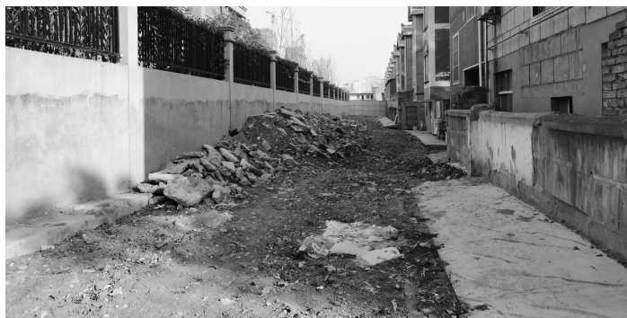
空地上堆满了建筑垃圾
