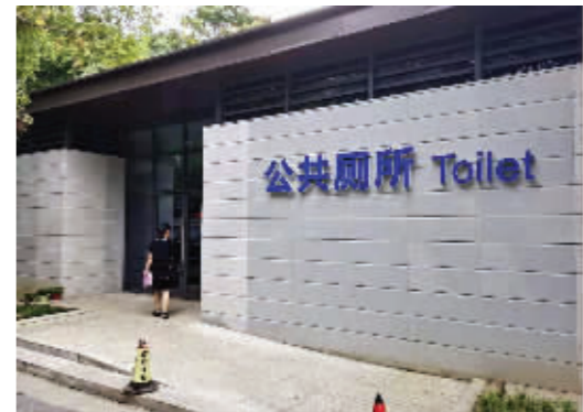
蓉湖大桥移动公厕改造后
