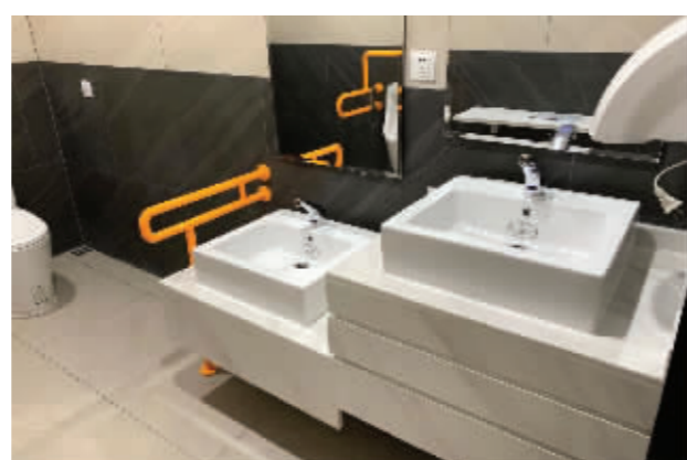
崇宁路第三卫生间洗手台
