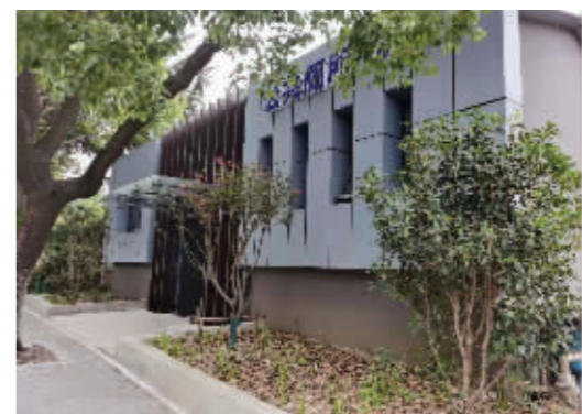
运河东路公厕改造后
