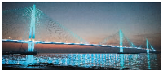
12月22日,南京江心洲长江大桥夜景照明系统完成调试
