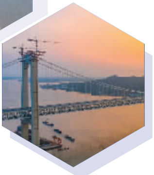
五峰山长江大桥
