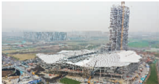
俯瞰扬子江国际会议中心施工现场
