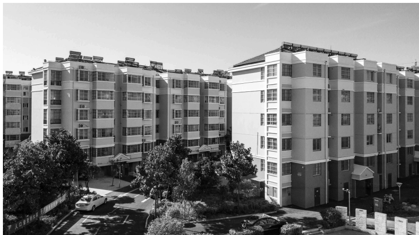
改造好的旧小区 通讯员供图
