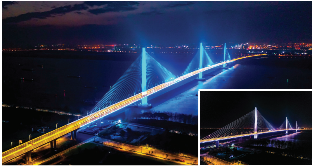
灯光调试中的南京长江五桥,美爆了! 中交二航局供图
