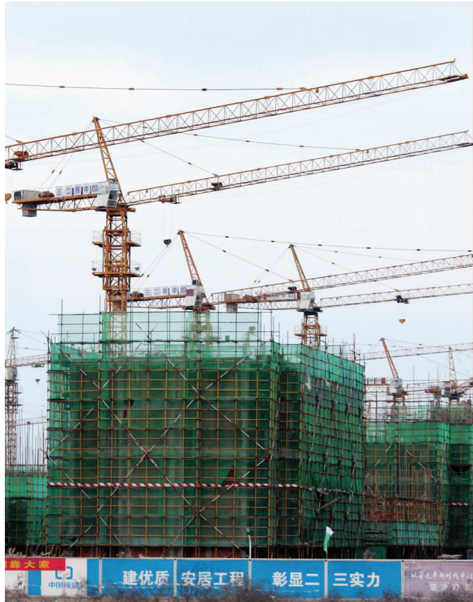
2019年2月,淮安朱码镇柴市棚户区改造保障房安置项目建筑工地 视觉中国供图
