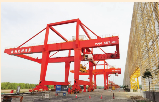
顺堤河作业区一期集装码头改建工程
