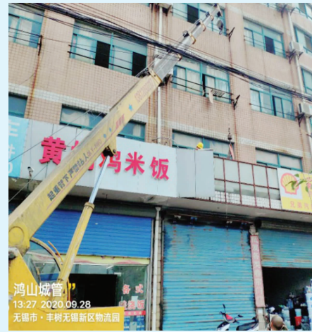
拆除破损店招牌牌
