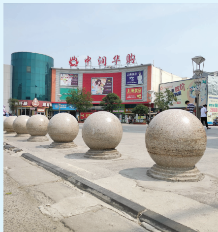
坊镇路商业街石墩修复后
