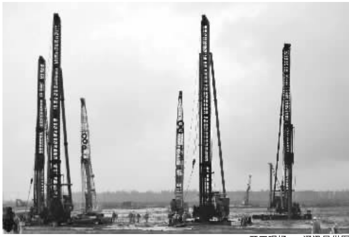
开工现场 通讯员供图
