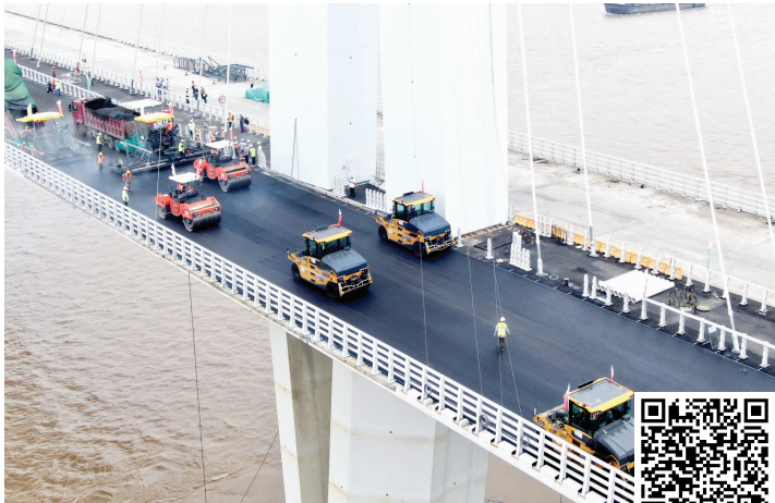
五桥正在进行桥面沥青铺装(扫码看视频)
