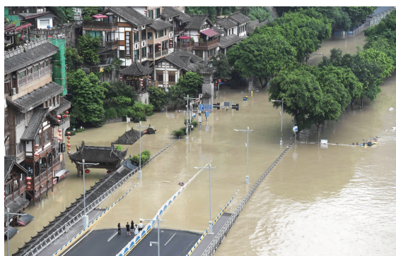
19日,重庆洪崖洞景区一楼被洪水淹没 视觉中国供图
