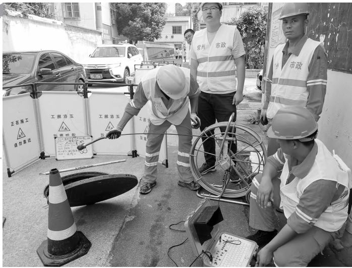
博爱路83号102医院宿舍雨污水施工现场 王锦萍 摄
