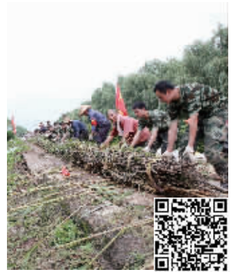
世业洲村民及安徽救援的工作人员正在扎草龙 潘伟 供图
